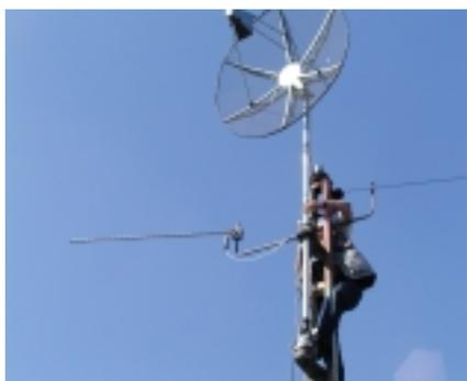
Die 13 cm-Antenne wird montiert
