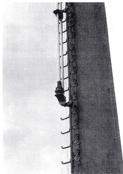
Der Rotorschlitten am Betonmast
