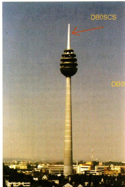
**Bild 4: Fernsehturm. Oben mit Pfeil der Antennenplatz im Random auf 270 m**
