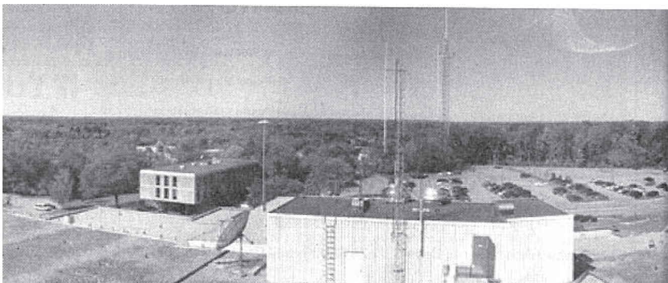
Antennen: 70 cm-Ausgabe 6 dB rundstrahlend horizontal, 23 cm-Eingabe Vertikal-Rundstrahler (Diamond), beide 36 m über Grund. Ausgangsleistung: 100 Watt auf 421,25 MHz VSB (Restseitenband).
