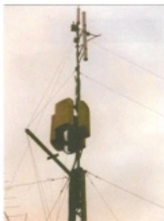
Für die 10 GHz-Eingabefrequenz, 10160 MHz, wurde der FM-ATV-Empfänger mit einem Videoausweiter ausgerüstet. Der Empfänger wurde an einer neuen Video-Audio-Umschaltung von DB0CD angeschlossen.
