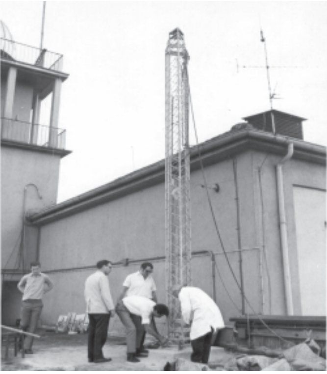
Antennen-Bauarbeiten bei DL0AK
