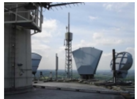
Endausbau der Antennenanlage
