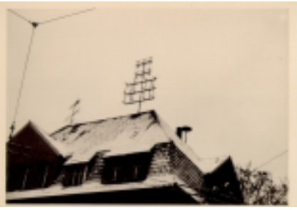
Antenne von DJ8DW auf einer Schule in Solingen, 72 El-Gruppe für 70 cm-ATV, 24 El-Gruppe für 2 m (1967)
