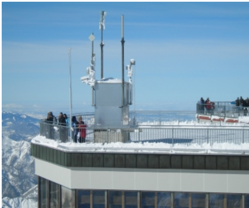
Besucherterrasse Österreich. Auf dem Gebäudeaufsatz werden die Antennen des Umsetzers OE7XZR installiert, nur wenig unter 3000 Meter. Blickrichtung des Fotografen ist Richtung Deutschland
