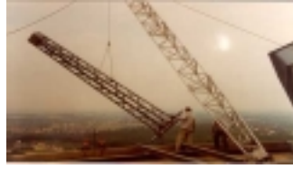
Der Mast kommt hoch...
