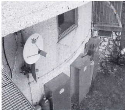
Unter einem Vorsprung gut geschützt die Linkantennen zu DBØQP und DBØQI
