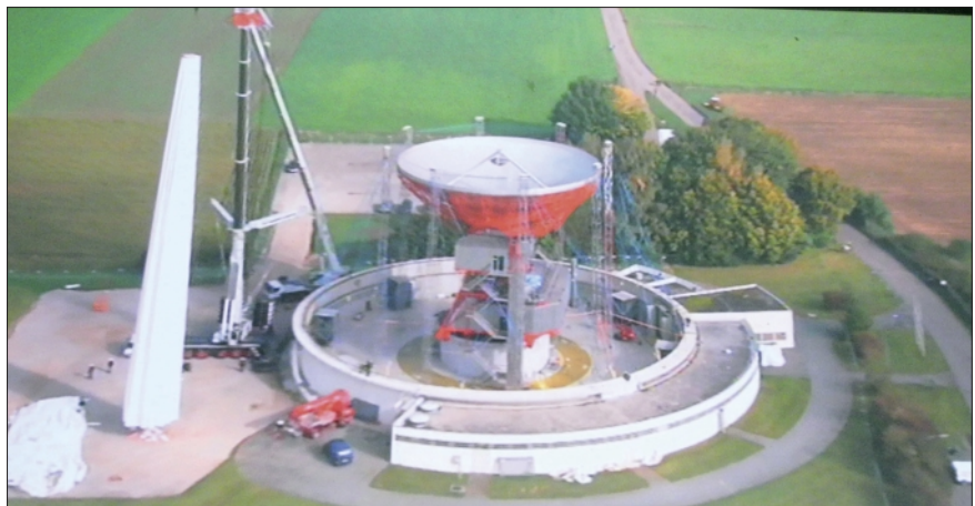
Die Erneuerung des Radom im Jahr 2012. Links die von einem Kran hochgezogene und wie ein Schirm eben noch zusammengefaltete Schutzhülle. (Screenshot INDOC-Film)
