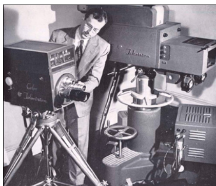
Links Einröhren-Farb-TV-Kamera-Prototyp, rechts 3-Röhren-RCA-Kamera
