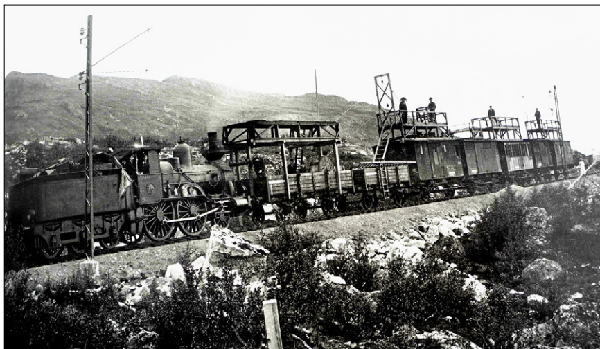
Eine Dampflokomotive hilft 1913 bei der 15.000-Volt-Ausrüstung einer schwedischen Bahnstrecke nördlich des Polarkreises.
