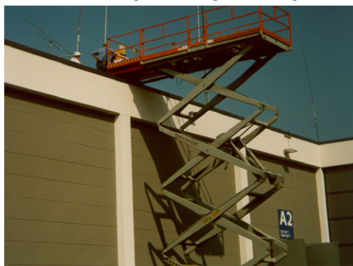
mit dieser Maschine geht es aufs Dach
