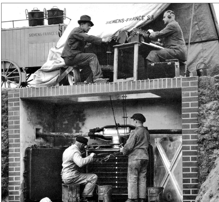
Pupinspulen verstärken zwar die Telefonsignale, jedoch auch das Nebensprechen. Es wurde mittels Kondensatoren kompensiert, hier in Kästen bei der Montage im sogenannten Verteilerbrunnen. Foto von der Strecke Paris-Bordeaux 1928.
