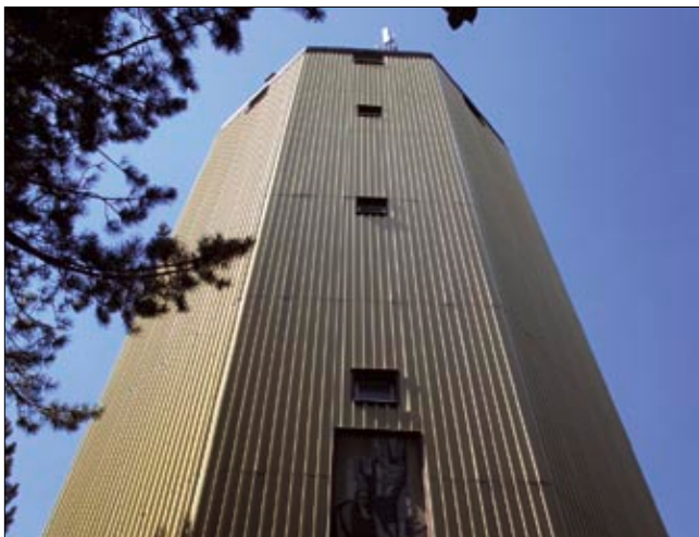
Neuer DBØQI-Standort auf dem Wasserturm in Vierkirchen nördlich von Dachau.
