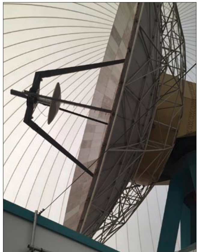
Sternwarte Bochum: schwenkbare 20-m-Schüssel im Radom
