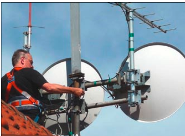
Jörg, DF3EI, gut gesichert beim Antennenaufbau auf dem Dach
