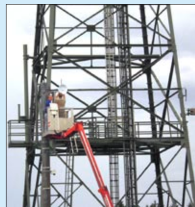
HAMNET-Antennen-Montage am Knüll
