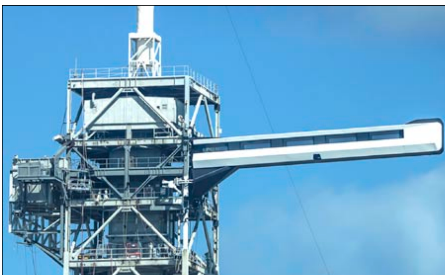
Raketen-Startturm mit Vorbereitungen für bemannte Flüge
