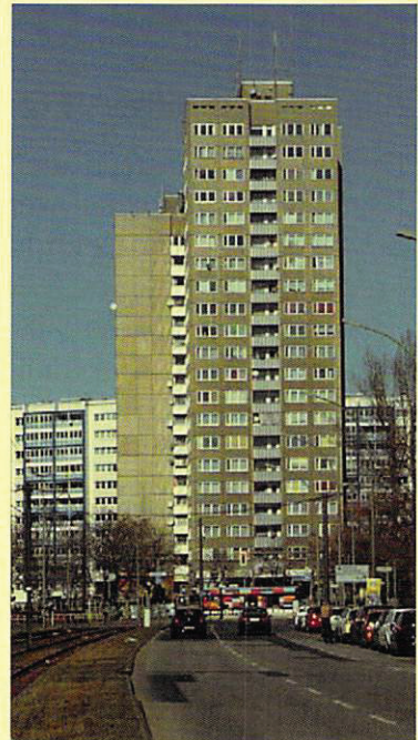
Bild 1: Bakenstandort oben auf dem Dach
