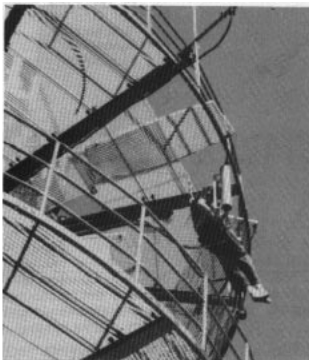
Bild 1: DL4FBN beim Antennenbau in 130 m Höhe
