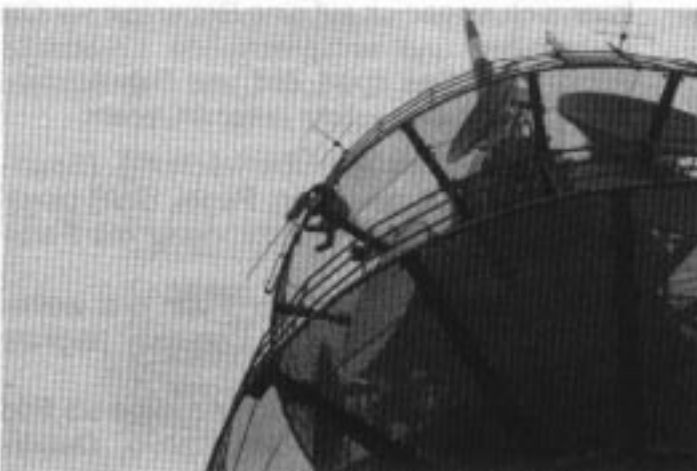
Bild 3: Montage der Antennen auf der Gitterplattform des FMT
