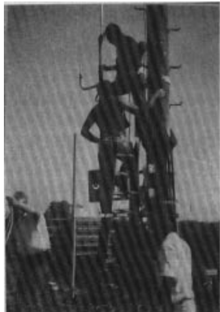
OMs aus A44 und P03 auf dem Dach des Landratsamtes beim Anbringen der Antennenanlage auf dem 23 m - Mast
