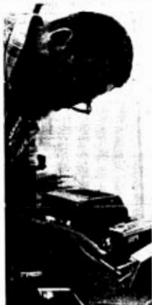
Jugendwart Olaf Möller überprüft die Anschlüsse der Fernsehsendeanlage.
