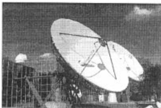
ASTRA-Uplinkstation in Betzdorf, Luxemburg Parabolantennen für Programmführung, Telemetrie und Telekomando
