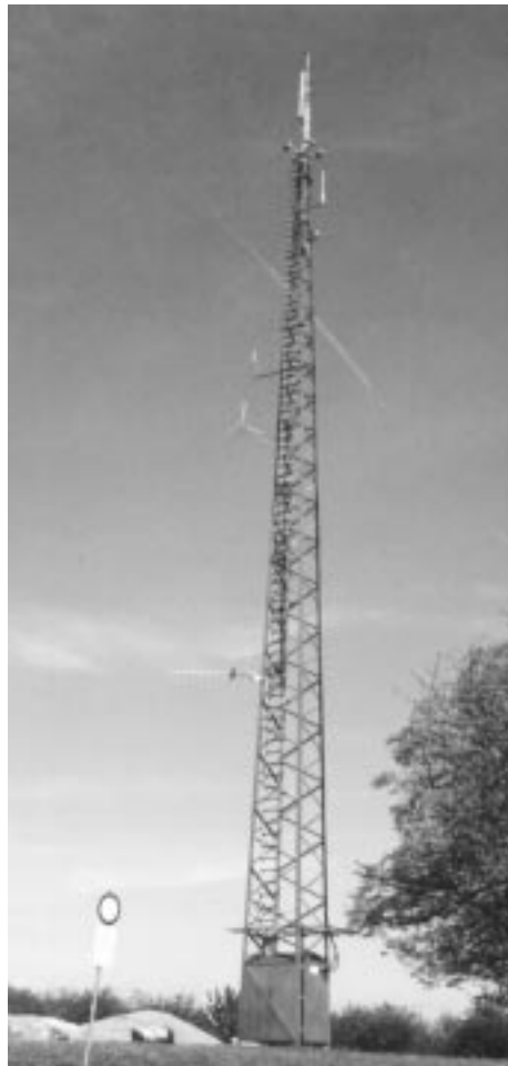
Die Antennenanlage von DBØRV
